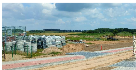
Zdj. 2. Grunty orne we wschodniej części obszaru opracowania
