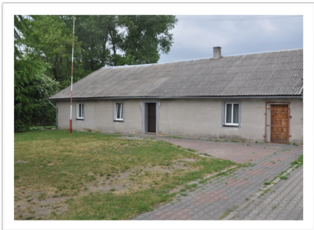
Rys. nr 12. Planowana do remontu świetlica wiejska w Koszelewach.
