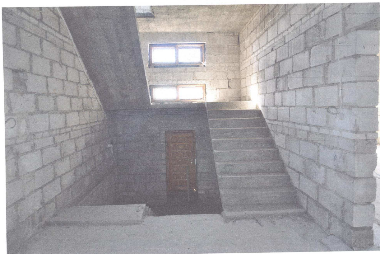
KLATKA SCHODOWA Z POZIOMU I PIĘTRA NA PODDASZE
