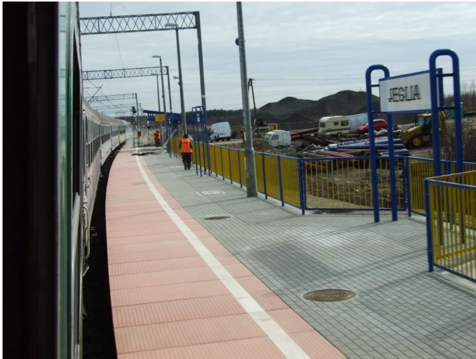
Rys. nr 6 Fotografia przystanku PKP.
