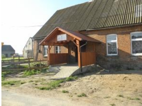
Rys. nr 7 Budynek Ochotniczej Straży Pożarnej w Jegli - świetlica.
